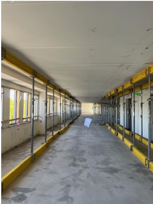
Figur 12. Stämpat bjälklag innan sågning
