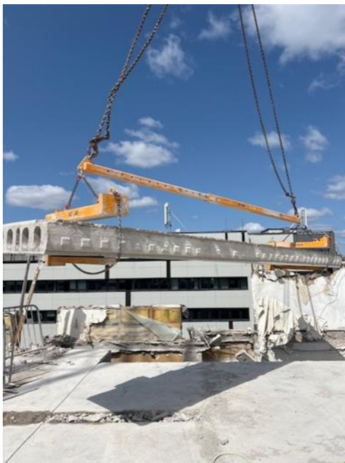
Figur 13. Lyftoket som använts vid demontaget
